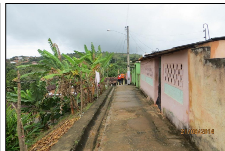
Além das bananeiras, o talude exibe declividade elevada, subvertical, potencializando o risco.
