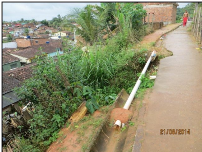
Topo da encosta mostrando ruptura das canaletas de drenagem, expondo a tubulação.
