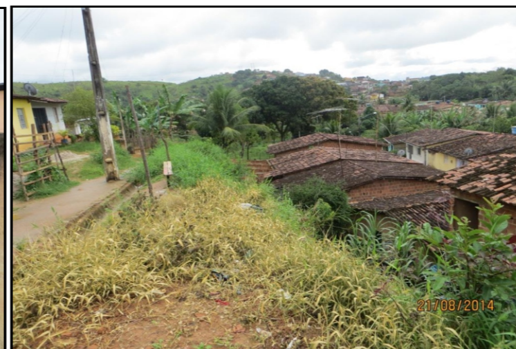
As casas na base do talude da Rua da Barreira estão construídas muito próximas, sem respeitar a distância mínima de segurança, favorecendo o risco de atingimento em caso de deslizamento do topo da encosta.
