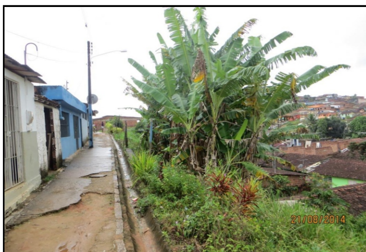
Trechos da encosta com bananeiras plantadas, as quais favorecem a infiltração da água.
